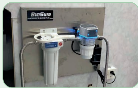
Maintenance préventive des canalisations d'eau
